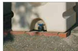
Protection de la vanne, moulée dans la cuve.
